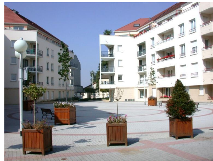
Immeuble collectif à Compiègne
