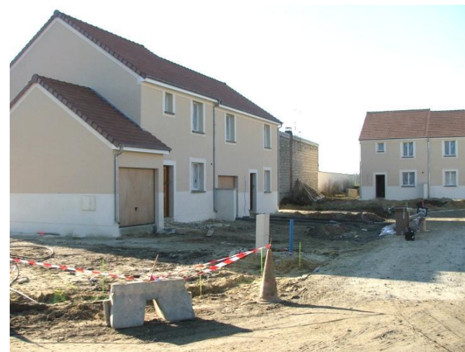
Lotissement en construction à Saint-Vaast-Les-Mello
