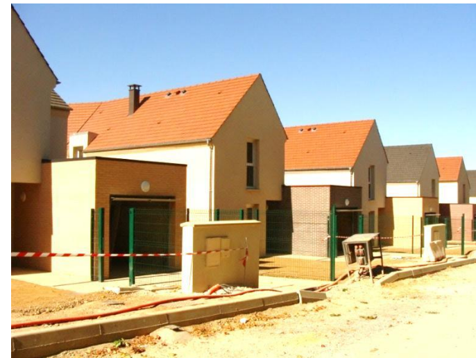
Construction de logements individuels à Nogent-sur-Oise
