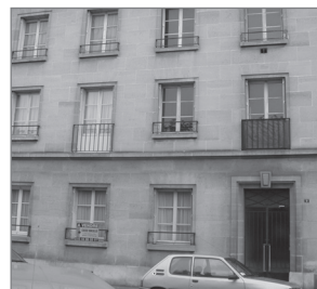
Logements collectifs privés à Compiègne
