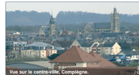
Vue sur le centre-ville, Compiègne. La Zone de Protection du Patrimoine Architectural Urbain et Paysager de Compiègne a été mise en place en 2006, elle a la particularité d'être divisée en deux parties. L'une concerne le centre-ville élargi, l'autre un périmètre autour de l'Abbaye de Royallieu.
