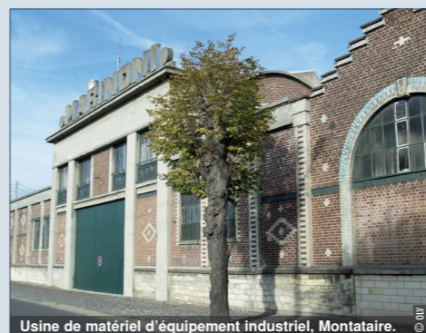
Usine de matériel d'équipement industriel, Montataire.
