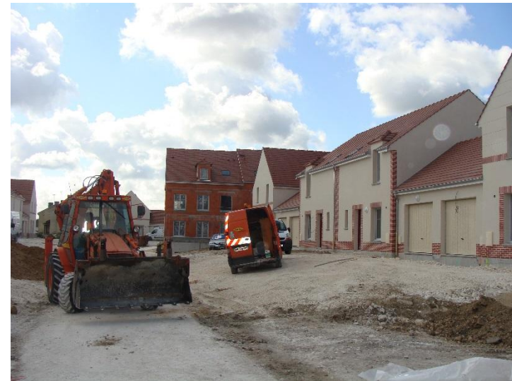
Projet en construction / Crédit photo Oise-la-Vallée
