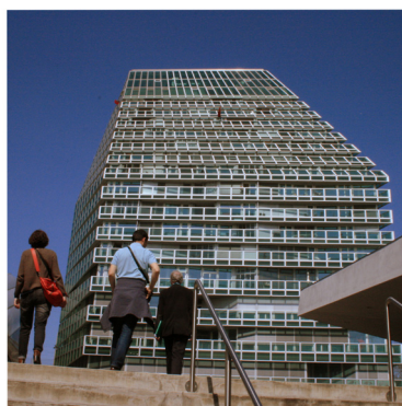
Vue sur la deuxième opération inaugurée en 2008, comprenant bureaux et logements.
