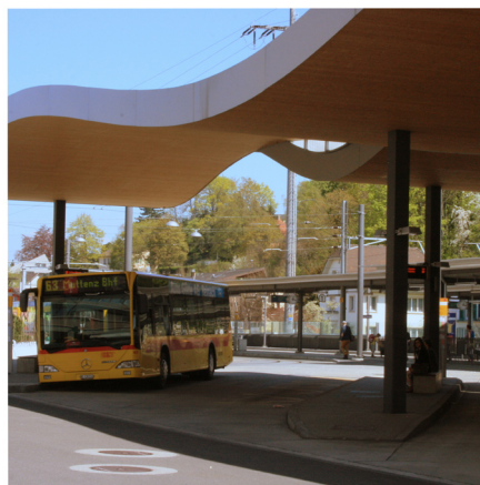
Quel que soit le mode de transport utilisé, les quais sont à la même hauteur pour une meilleure circulation piétonne.
