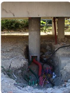
Des colonnes de béton servent d'écrin pour passer les gaines et réseaux techniques.
