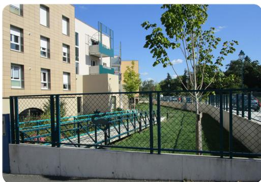
Les bas d'immeubles sont conçus en forme de douves qui fonctionnent comme des réservoirs tout en permettant à l'eau de s'écouler en période de crue.
