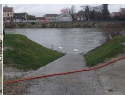
La mise à l'eau
