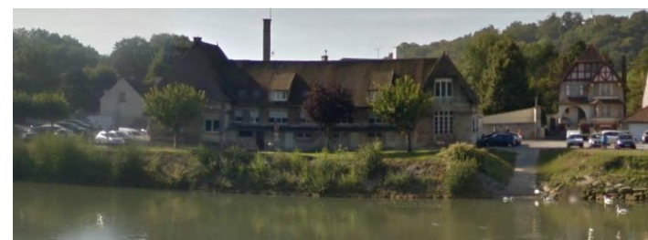
Vue depuis l'autre rive – un bâtiment remarquable
