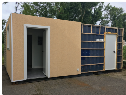
Les modules sont réhabilités et équipés en usine
