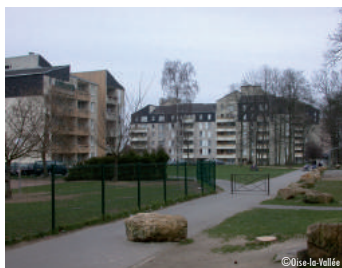
Ensemble d'habitat collectif situé dans le quartier des Terriers à Pont-Sainte-Maxence
