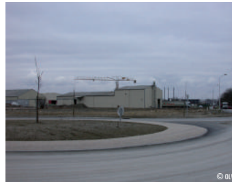
Domaine industriel de Pont-Brenouille en construction photographié en 2005
