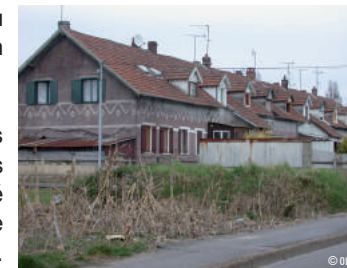
Pont-Sainte-Maxence, entre la rue Pasteur et le quai Mesnil Chatelain, Anciennes maisons ouvrières en bande (3 bandes)
