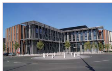
Bâtiment de l'entreprise Brezillon - Margny-les-Compiègne Architecte : ARVAL. - 2013
