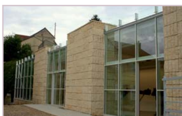
Maison de la Pierre Saint-Maximin Architecte : Bruno CROIZÉ 2008
