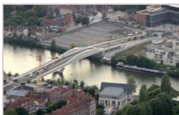
Pont Neuf - Compiègne Architecte : Yves PAGÈS. - 2011
