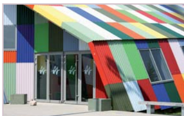
Espace de rencontres - Montataire Architectes : Raphaële PERRON et Laurent CHARPIN. - 2007
