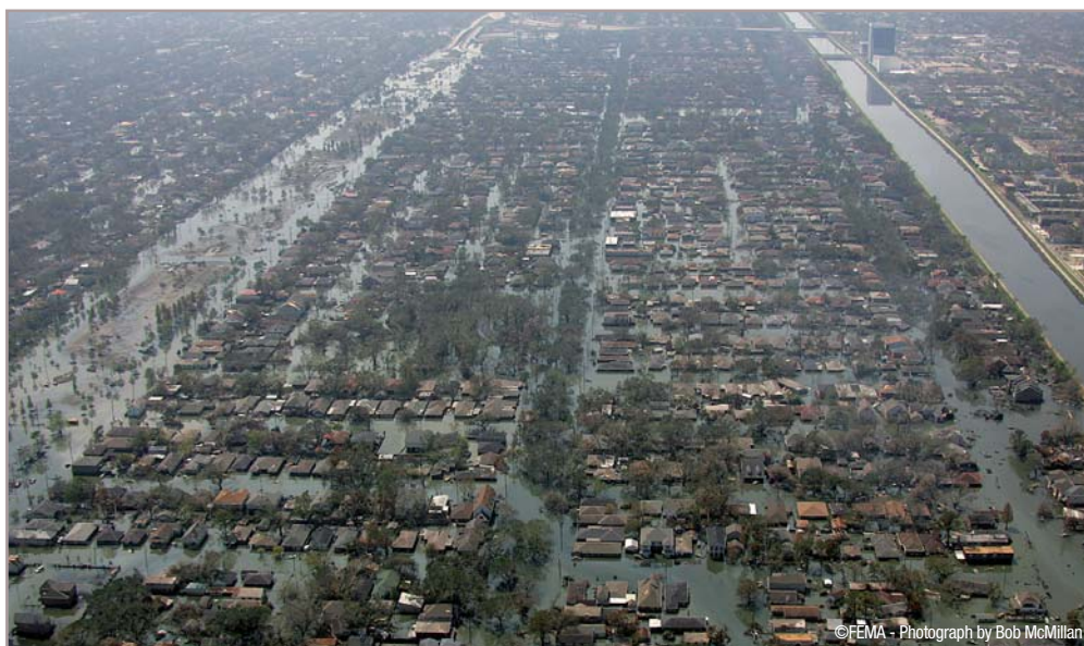
Nouvelle Orléans 2005 : Inondation suite à la rupture des digues engendrée par l'ouragan Katrina
