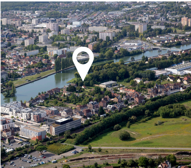
Vue sur le site étudié sur la commune de Venette
