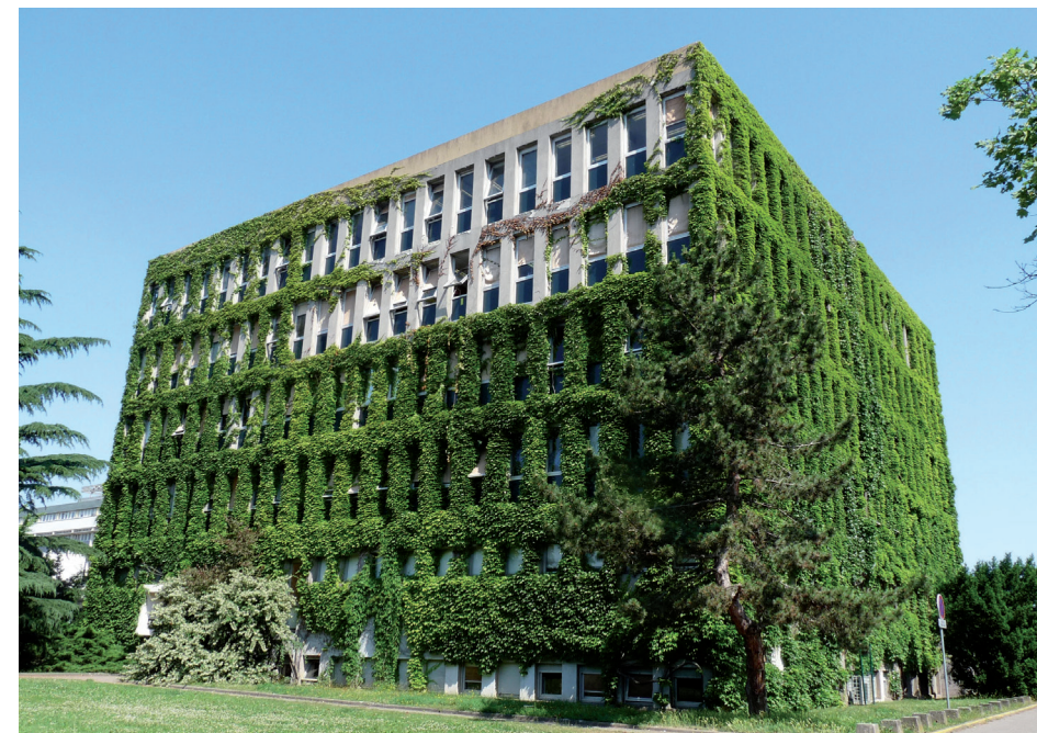
Exemple de bâtiment végétalisé. © ADEUS.
