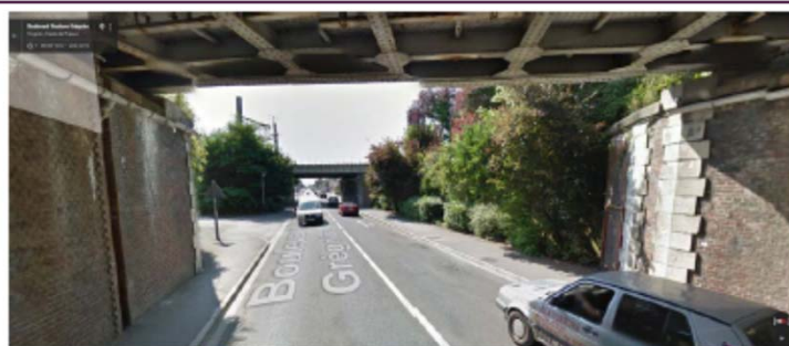
Aujourd'hui, un accès inconfortable et dangereux pour les piétons
