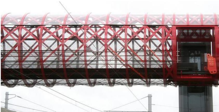
La passerelle ferroviaire nécessite des protections latérales pour la sécurité à la fois des usagers et des trains. Le volume complet procure une solution structurelle unique.
