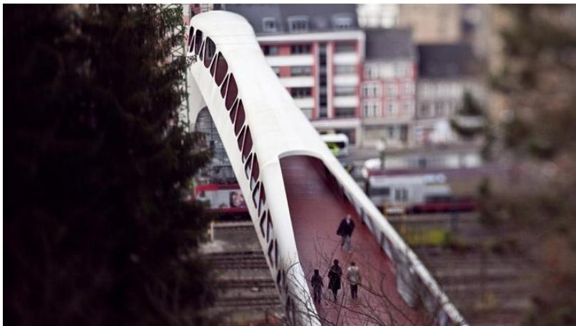
Le projet se présente sous forme d'un objet unique caractérisé par une volumétrie simple et épurée, la structure de la passerelle est réalisée par une surface homogène en acier. La surface est peinte en gris clair à l'extérieur pour accentuer les lignes et en rouge oxyde de fer à l'intérieur pour rappeler la terre rouge.
