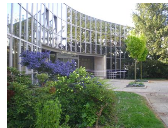
Façade arrière de la mairie, vitrée et typique des années 80/90
