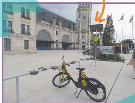
Borne de prêt alimentée par des panneaux solaires
